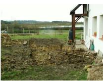
Le chantier est loin d'être terminé, la surface totale à creuser étant de 9 m x 3 m sur une profondeur de 1 m à 0,60 m (selon les endroits, vu la pente du terrain).
